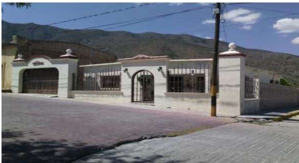
FACHADA HABITACIÓN RESIDENCIAL
