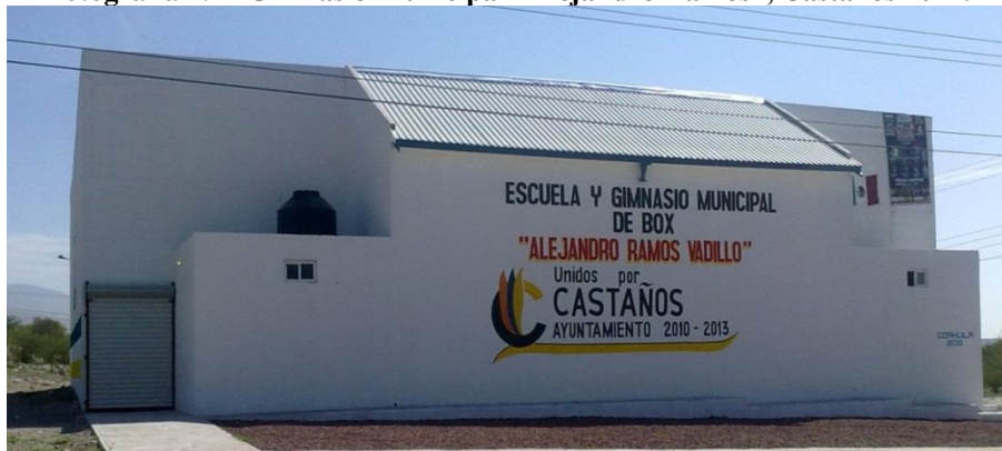
Fotografía 2.11 Gimnasio Municipal “Alejandro Ramos”, Castaños 2012.
