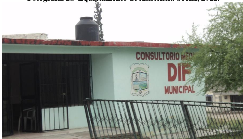
Fotografía 2.9 Equipamiento de Asistencia Social, 2012.
