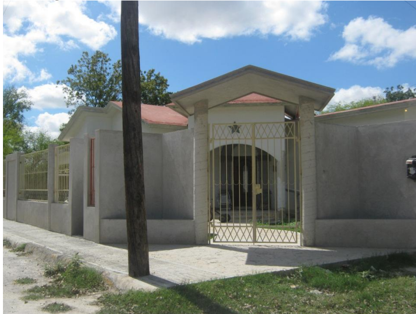
Fotografía 2.6 Vivienda de auto construcción, Zona Centro, Nava
