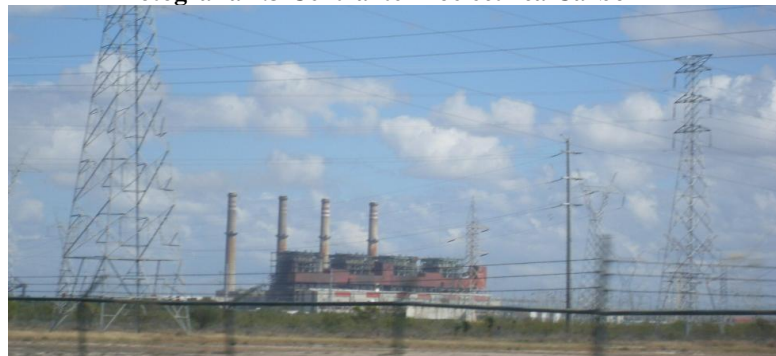
Fotografía 2.3 Central termoeléctrica Carbón II
