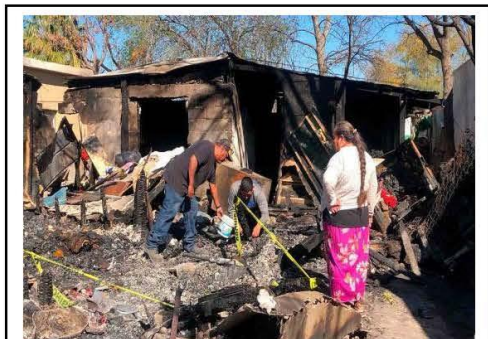
Figura 20. Vivienda consumida por incendio
